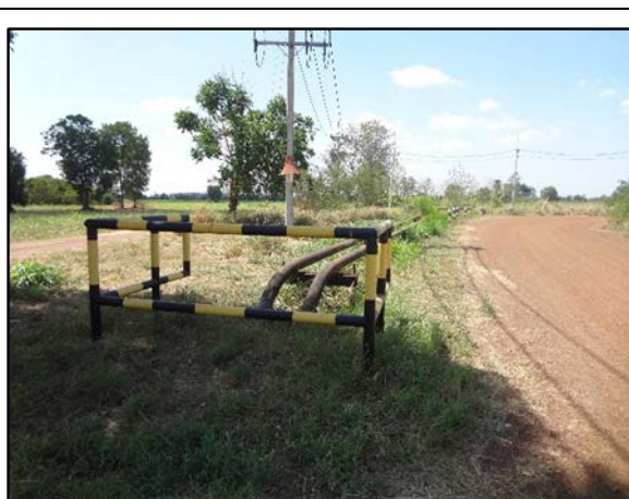
ภาพที่ 2.3-5 การติดตั้งรั้วกันชนแนวท่อ
